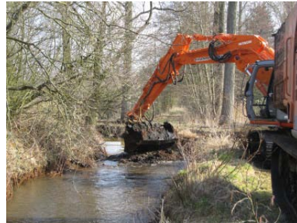
Fig. 1: Dredging in the Scheppeilijke Nete.
