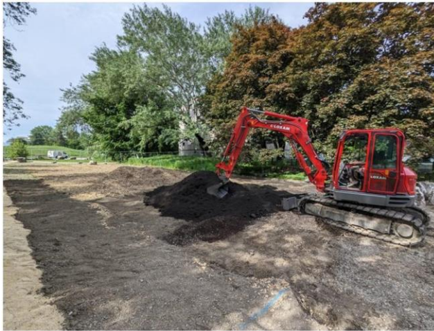
Mise en forme des sédiments sur le terrain
